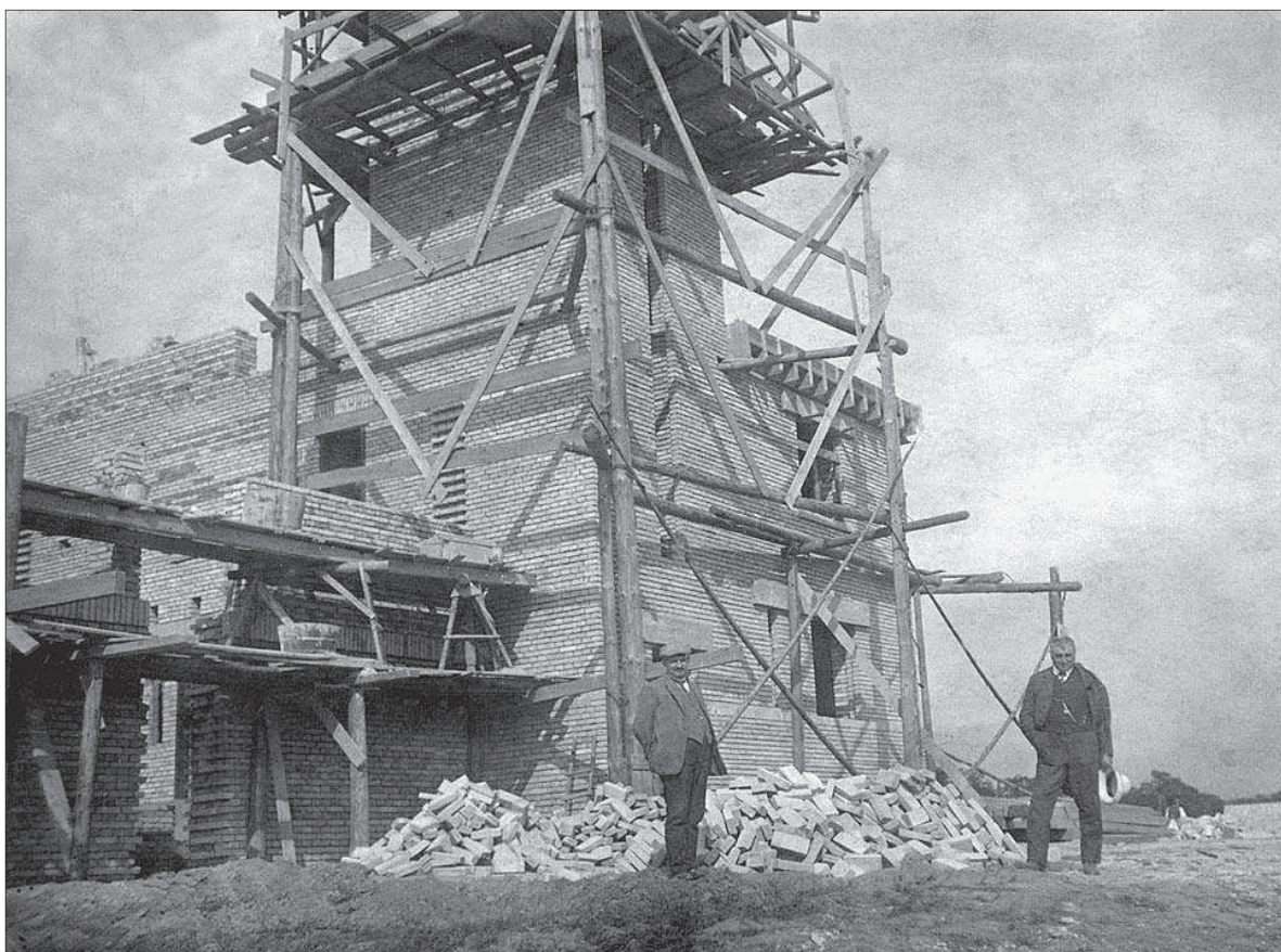
Stavba základní konstrukce v průběhu letních měsíců roku 1925 (ACČSH Lužná/Lišany)
