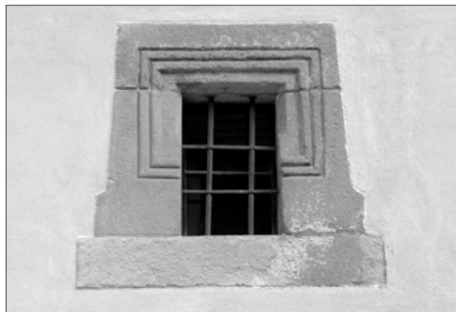
Goticko-renesanční okno na špýcharu čp.1 v Třebízi.
