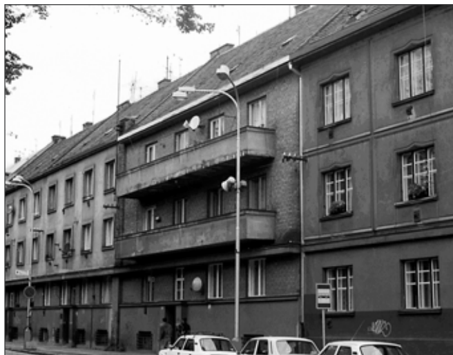
Rakovník, ulice Na Sekyře, kvalitní bytové domy vystavěné ve dvacátých a počátkem třicátých let minulého století, z východní strany (zprava) od arch. Bohumila Hübschmanna, uprostřed od arch. Jana Němce a zcela vlevo od ing. arch. F. A. Libry.
